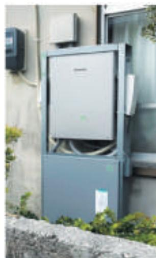
家庭に設置された蓄電池。太陽光発電での電力を、蓄電池に充電させて、電力供給を調整しています。
