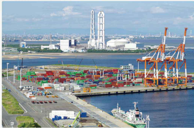
火力発電所の多くは、海外から運ばれた燃料をすぐに利用できるよう、大きな港の近くにありま(写真は三重県の川越火力発電所)。
