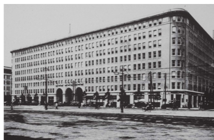
1923年、東京に完成した丸の内ビルディング(丸ビル) 写真:三愛地所
