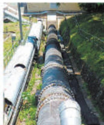
**流れこみ式水力発電**をしている中里発電所：茨城県にあり、1908（明治41）年に発電が開始され、現在も使用されています。
