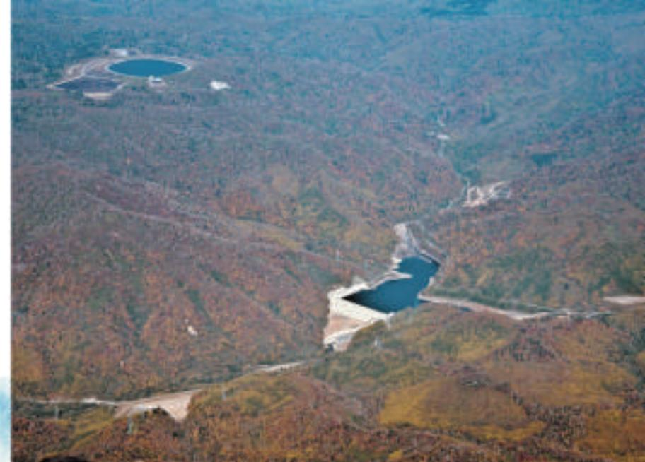
**京極発電所**：北海道虻田郡の台地に設置したプール形式の上部調整池と京極ダム間の総落差約400mを利用した揚水式発電所です。
